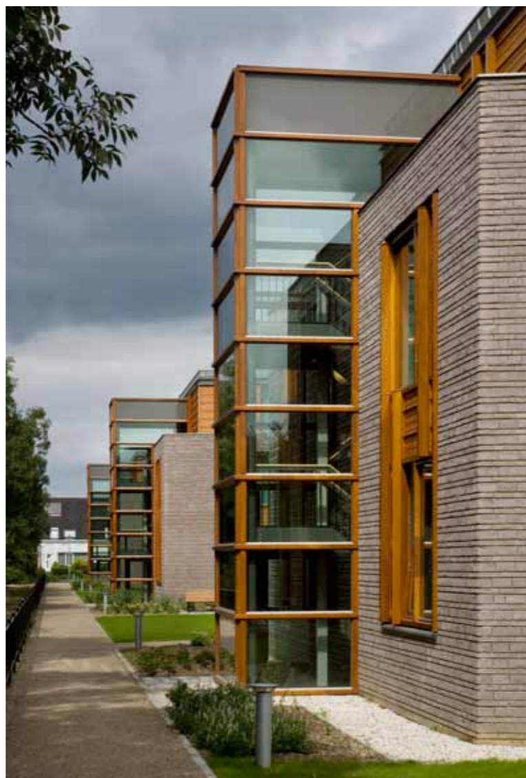
Architecten aan de Maas, La Valence, Maastricht, 2007
